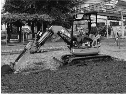
図2-1 土の入れ替え作業
